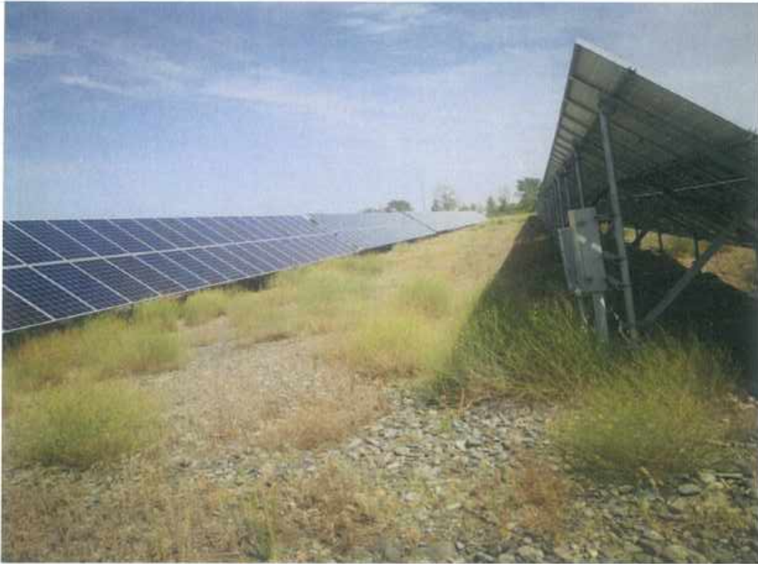
光伏系统区土地平整 1
