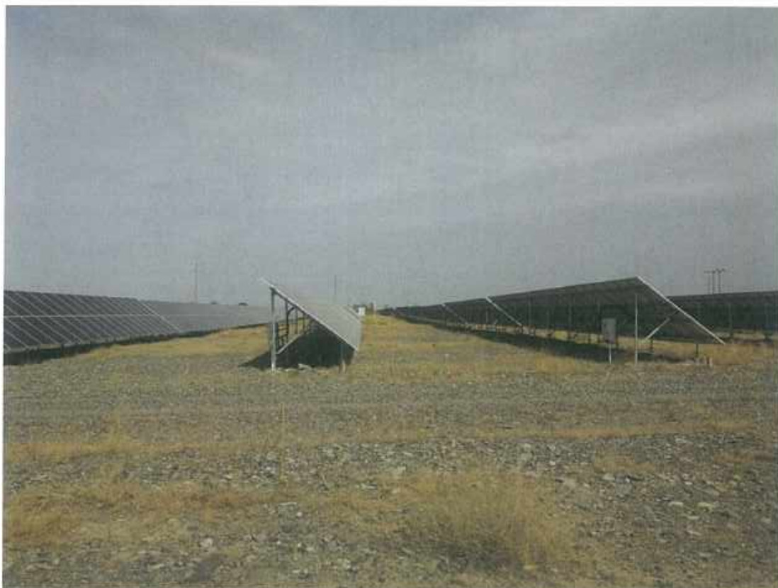
光伏系统区土地平整 3
