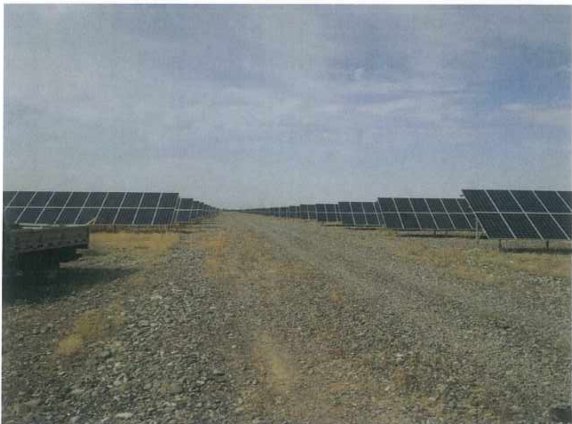
道路区土地平整与砾石压盖 2
