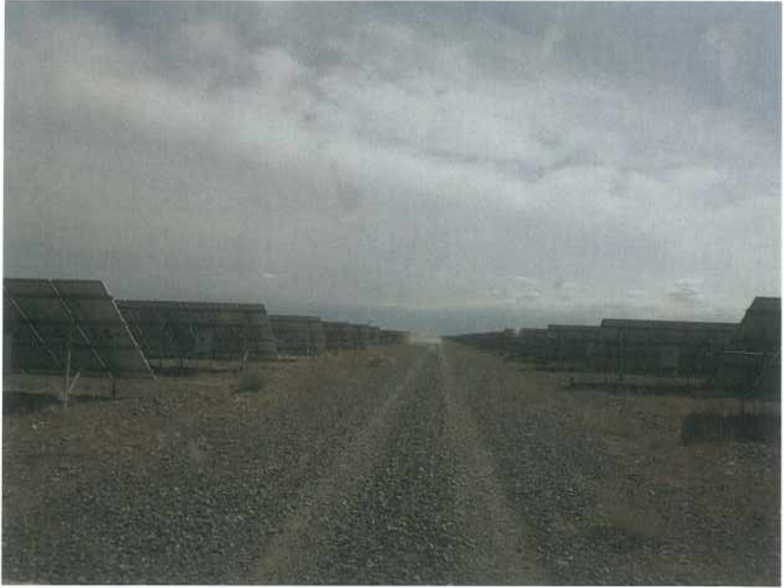
道路区土地平整与砾石压盖 3
