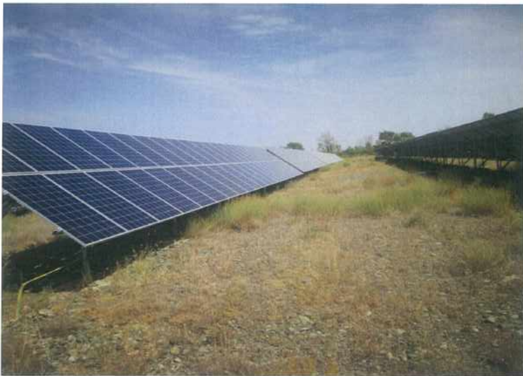
光伏系统区土地平整 2
