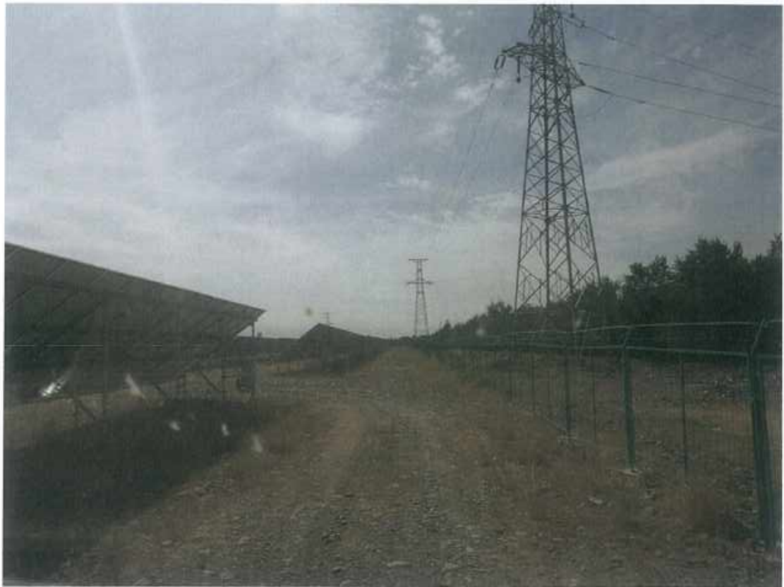
道路区土地平整与砾石压盖 4
