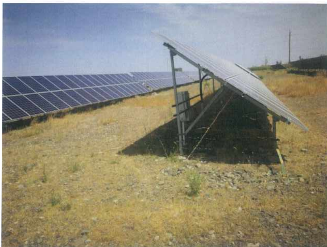
光伏系统区土地平整 4
