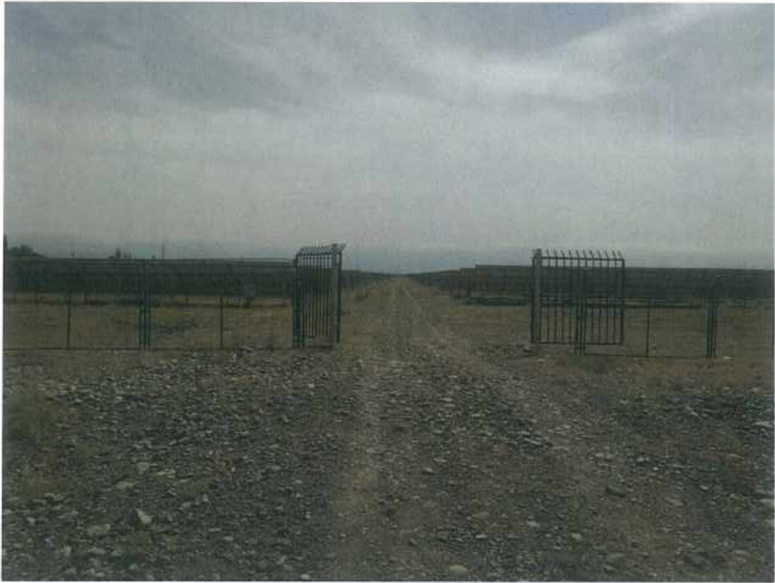
道路区土地平整与砾石压盖 1
