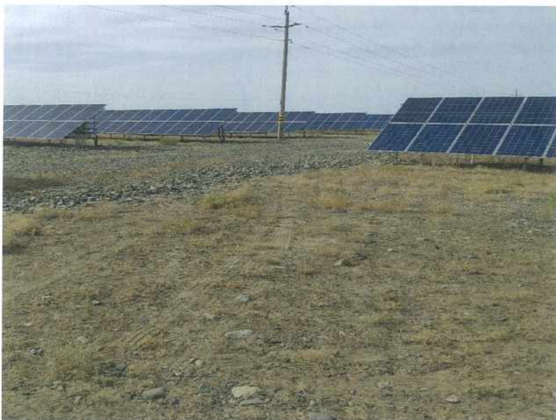
施工生产生活区土地平整与砾石压盖 3
